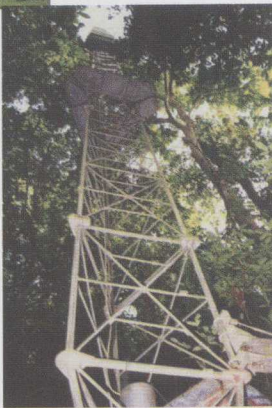
热带雨林中的观测铁塔 马铭/摄
